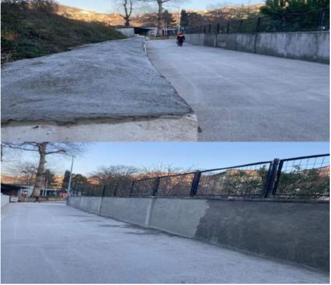
*BETON YOL YAPIMI
