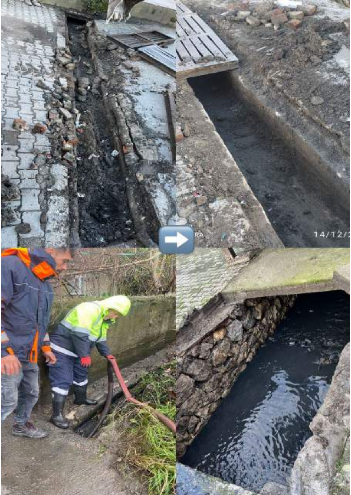
*YAĞMUR SUYU KANALI TEMİZLİKLERİ
