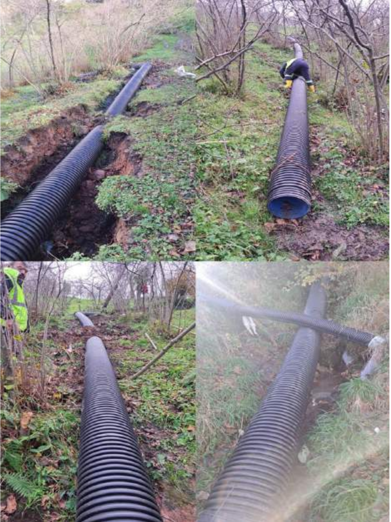
*KORUGE BORU DÖŞEME ÇALIŞMASI
