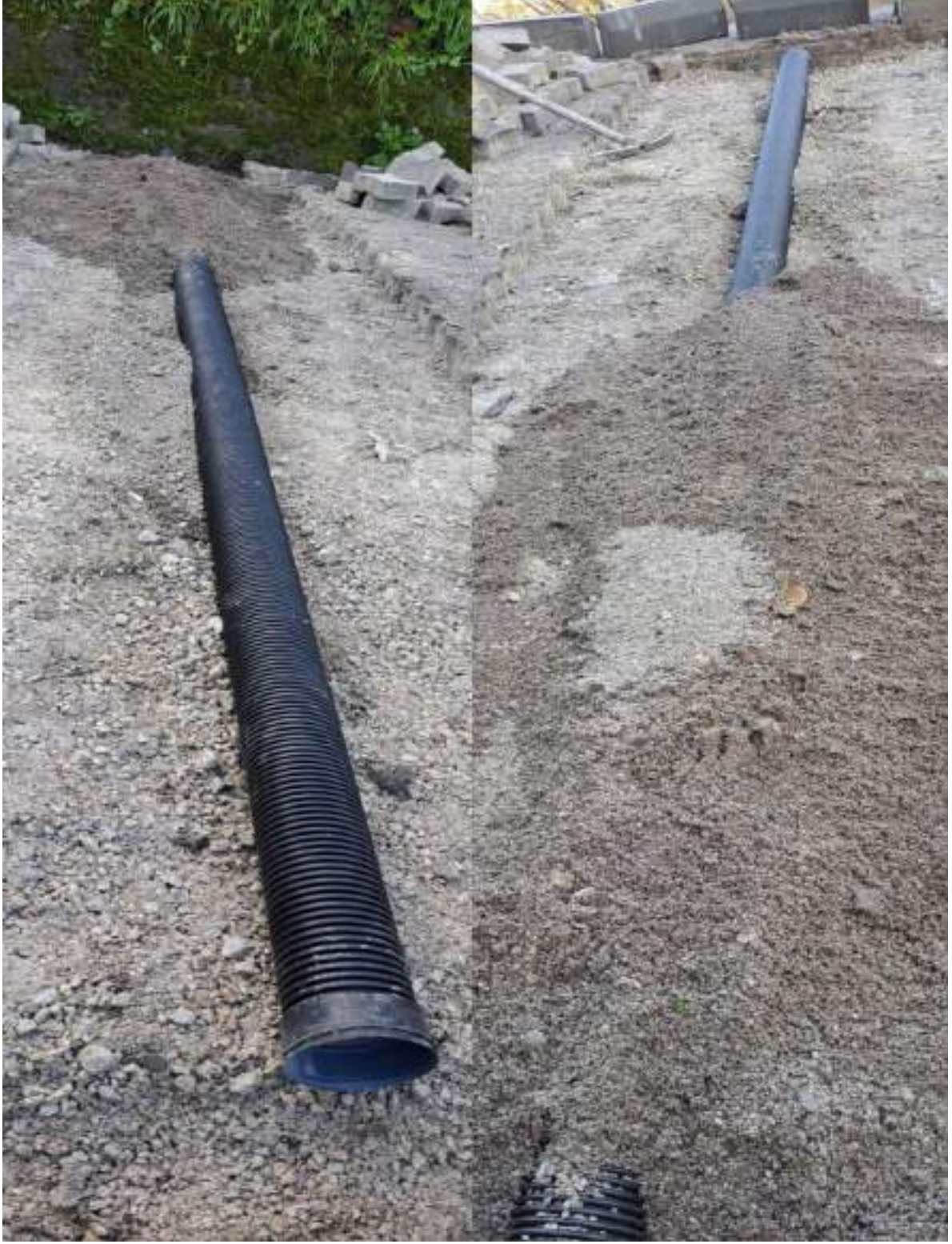
*KANALİZASYON ALT YAPI ÇALIŞMASI
