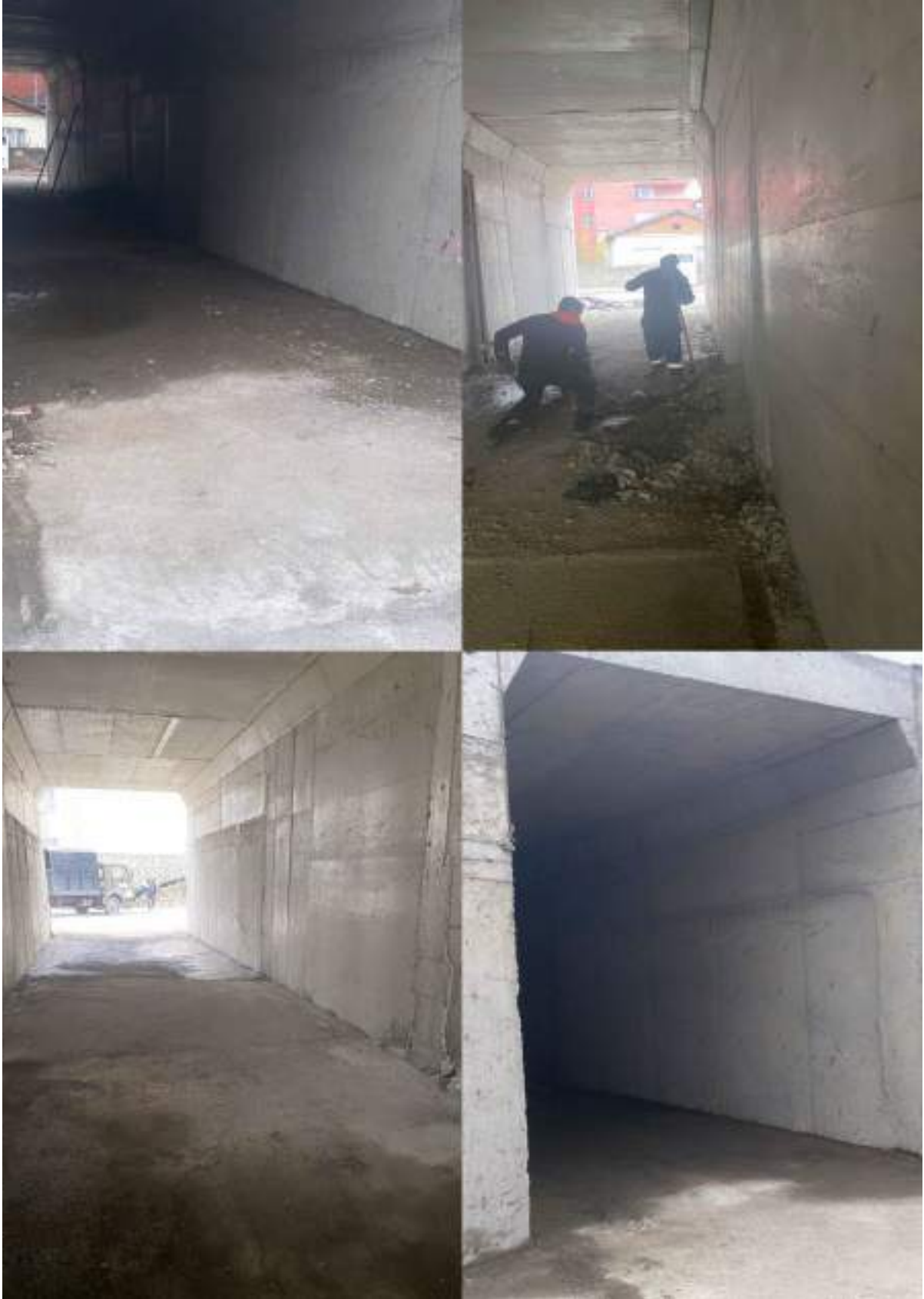
*MERKEZ MAHALLESİ ALT GEÇİT ÇALIŞMASI
