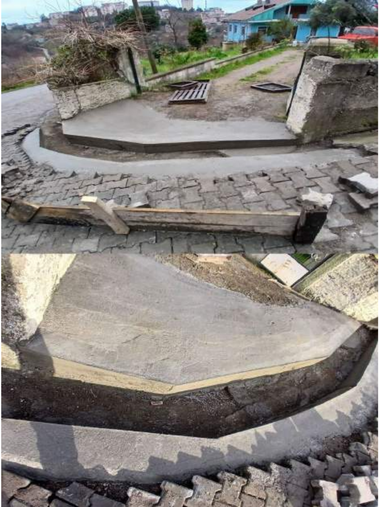
*YAĞMUR SUYU KANALI YAPIMI
